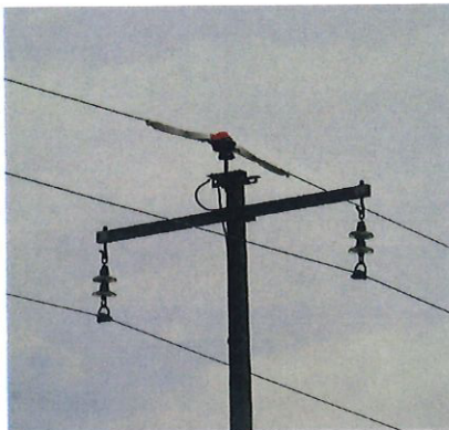
Прилог 1. Пример постављања пластичних покривки на изолаторе
