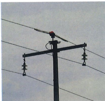
Прилог 1. Пример постављања пластичних покривки на изолаторе
