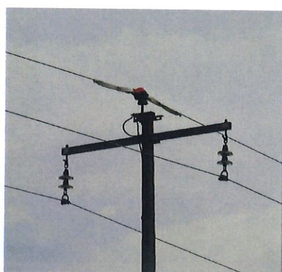
Прилог 1. Пример постављања пластичних покривки на изолаторе
