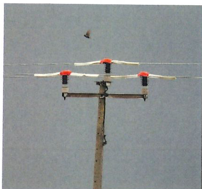
Прилог 1. Пример постављања пластичних покривки на изолаторе
