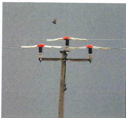
Прилог 1. Пример постављања пластичних покривки на изолаторе
